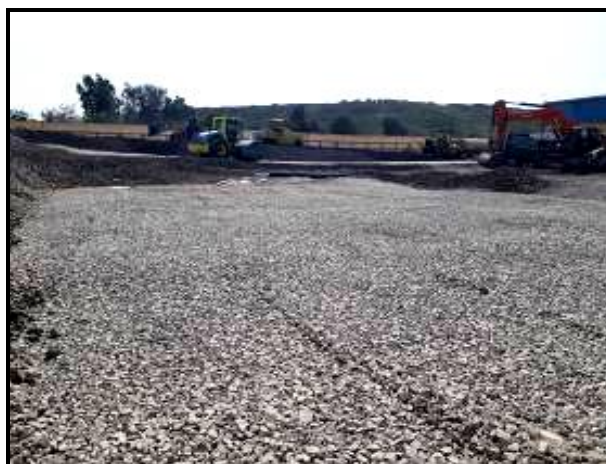
Figure 6. Mise en place de la couche de forme.
