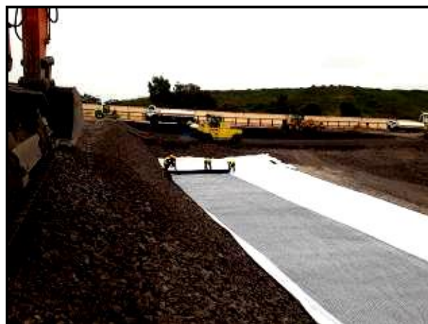
Figure 5. Mise en place du géotextile et de la géogridle
