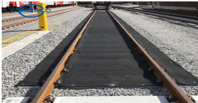
Figure 1. Géosynthétiques dans la route ferroviaire
