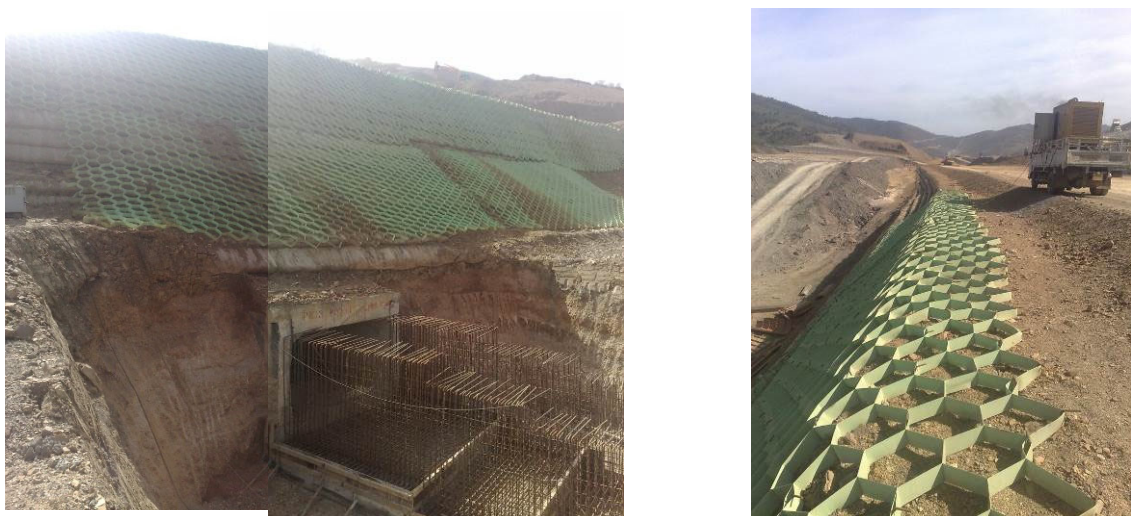
Figure 3. Protection du parement de l'ouvrage renforcé par géotextile (géotextile alvéolaire)
