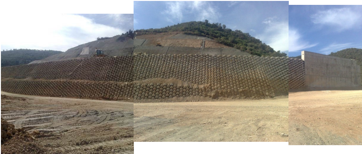
Figure 5. Massif renforcé par géotextile à parement Atalus (projet du lot centre / Autoroute Est Ouest)
